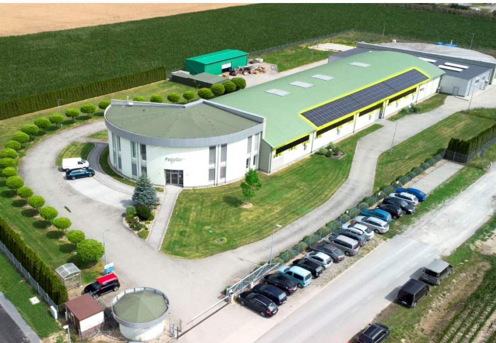
Siedziba firmy PRO-VENT
