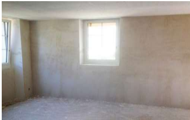
Gotowy tynk termoizolacyjny
