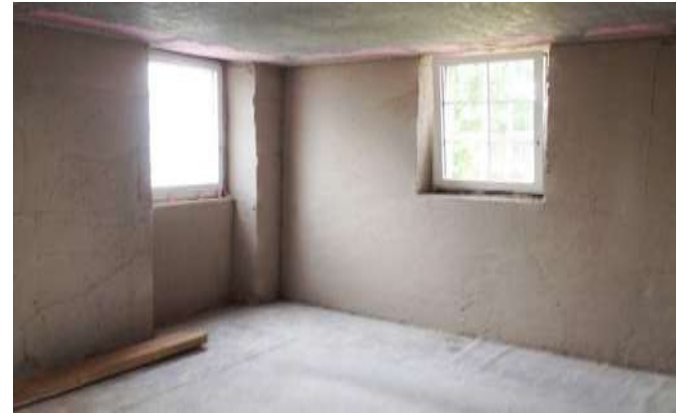
Gotowy tynk termoizolacyjny
